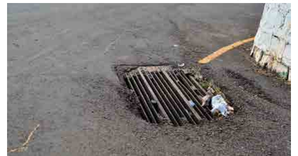
Serviço prevê dedetização de até 500 bocas de lobo
