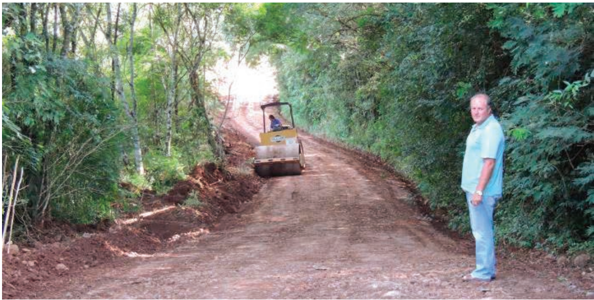
Nesta semana foi realizado o serviço na estrada que dá acesso à Linha Jacutinga
