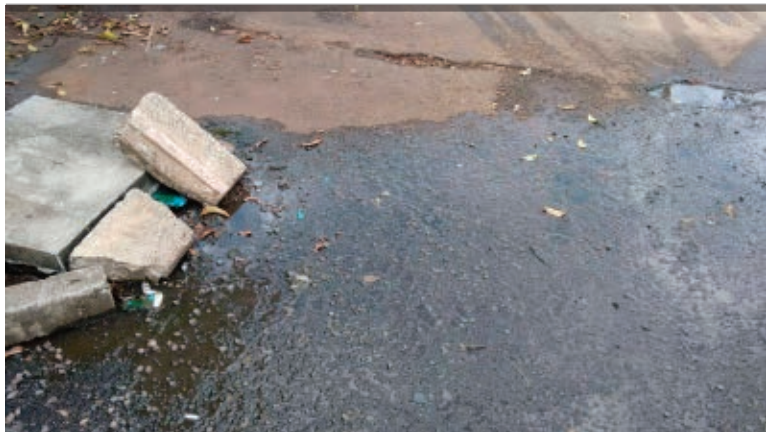
Esgoto a céu aberto na Rua 7 de Setembro, próximo ao Posto Molin, em São Miguel do Oeste. O leitor mencionou que já informou a situação à Vigilância Sanitária, porém a situação continua na mesma.
