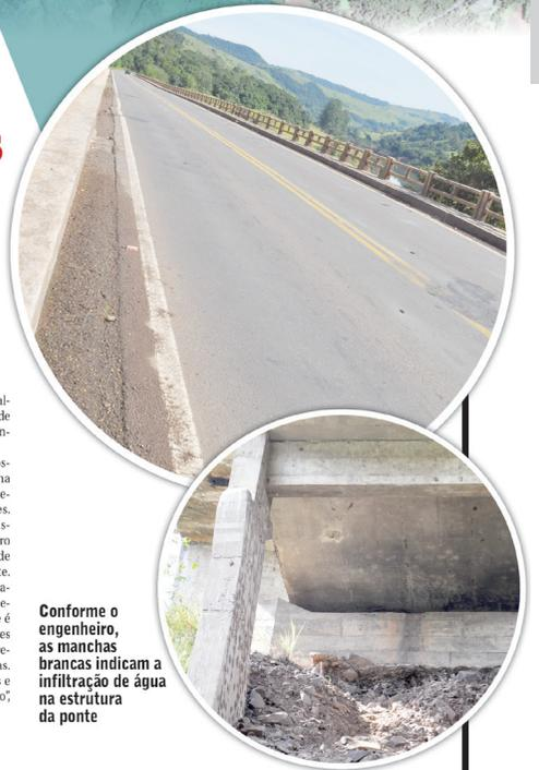
Conforme o engenheiro, as manchas brancas indicam a infiltração de água na estrutura da ponte
