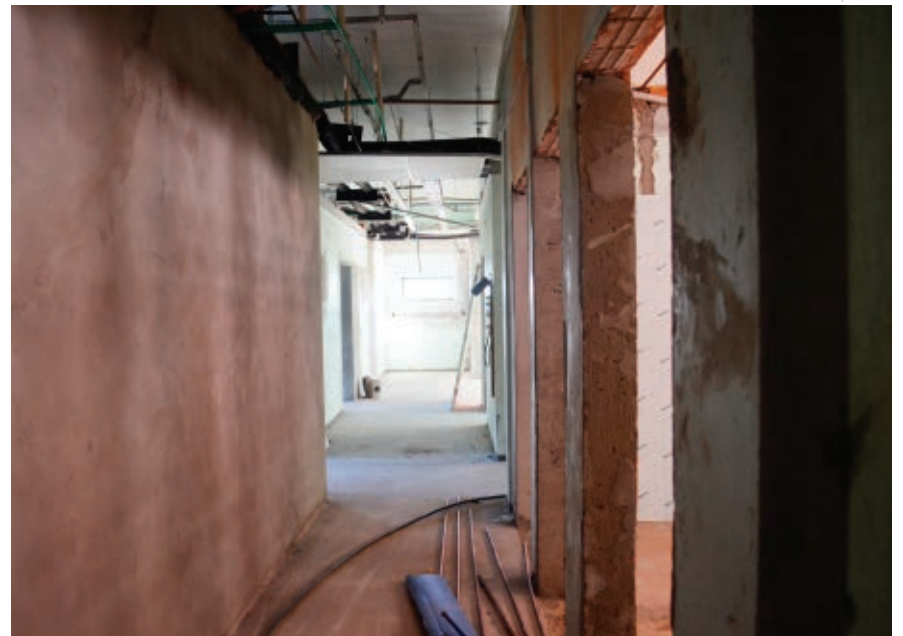
Instalação do elevador está em fase de conclusão
