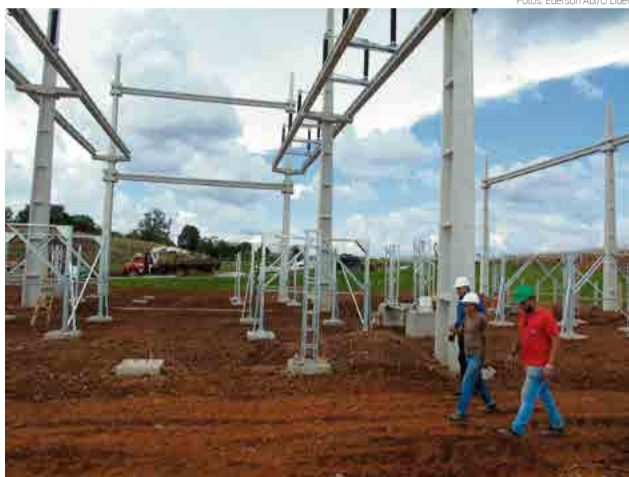
Valci Dal Maso e responsáveis técnicos percorreram obra nesta semana
