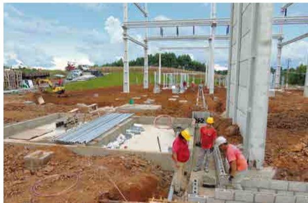
Com parede de proteção, trabalhadores fazem ajustes em área onde ficará o transformador de 70 toneladas
