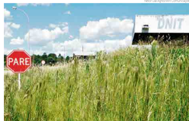
Balança controlaria o excesso de peso que danifica a rodovia
