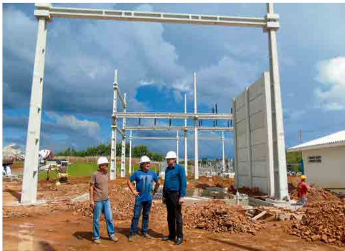
Subestação tem 21 postes de concreto e recebe materiais de vários países
