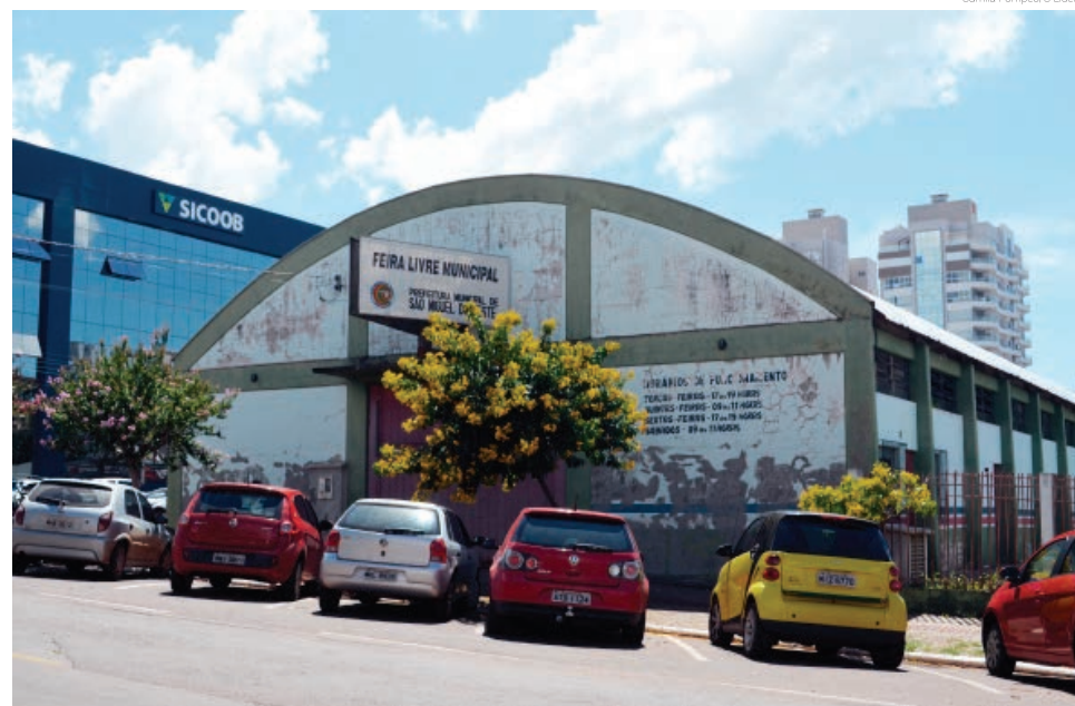
Trabalhos contemplam pintura interna e externa, além de trabalho de paisagismo
