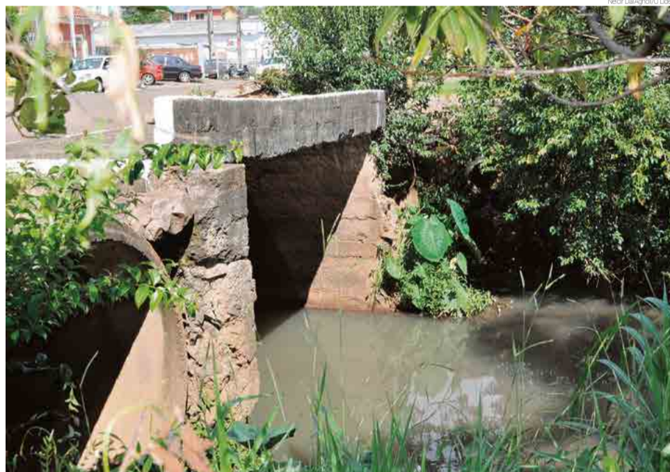
Na primeira etapa, rio será canalizado e pontes serão substituídas
