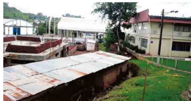
Construtora diz que obra está adiantada no local, após levantamento de toda a base
