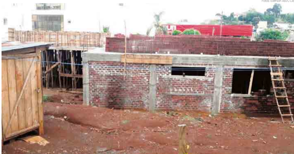
Primeira laje foi colocada em toda a extensão do Centro Municipal de Saúde
