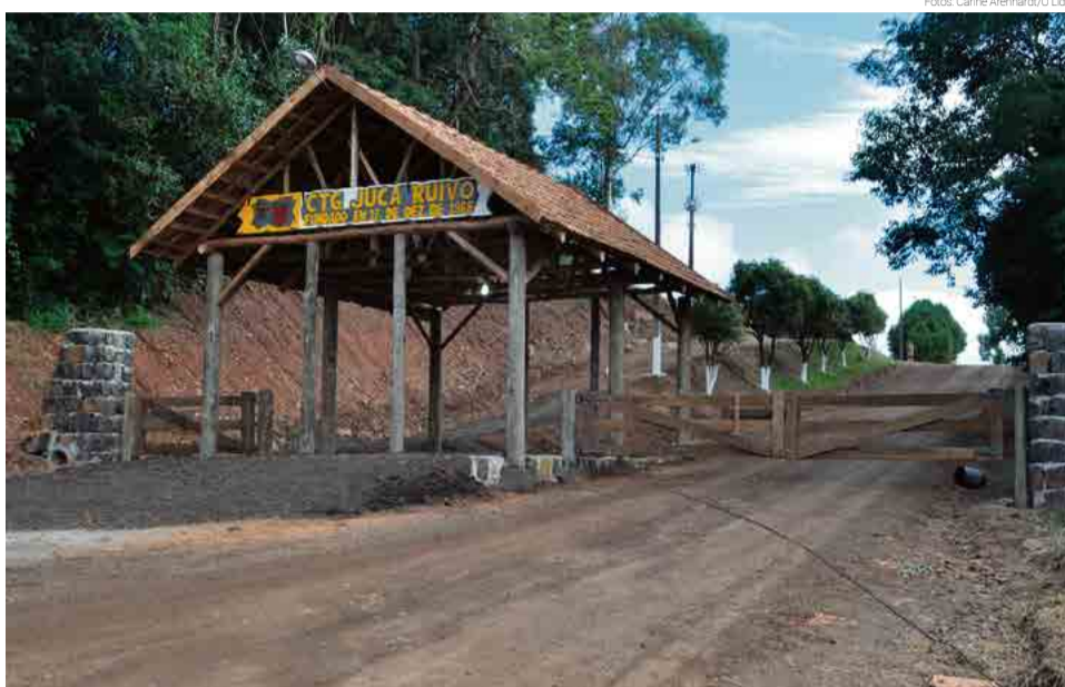
Construção do novo portal teve recursos de patrocinadores particulares
