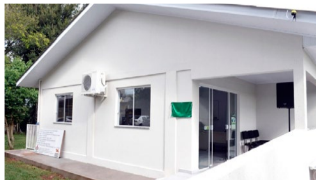
Novo prédio da Gerência Regional da Epagri de São Miguel do Oeste teve o investimento de R$ 185 mil do governo do Estado, por meio do SC Rural
