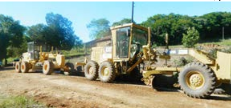
Dois motoniveladoras estão realizando o trabalho de melhorias
