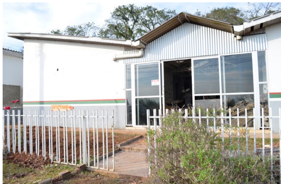
Serão investidos em torno de R$ 500 mil na reforma e construção do prédio onde irá funcionar o Casep
