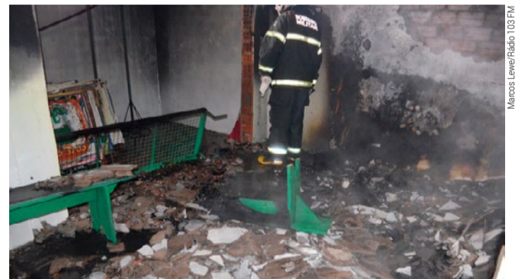
Dentro do depósito, segundo os responsáveis, eram armazenados alguns colchões que foram destruídos pelo fogo
