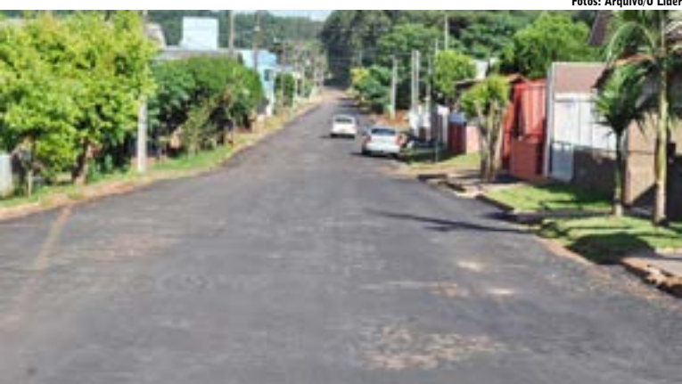
Asfaltamentos também foram realizados em ruas e avenidas de Maravilha
