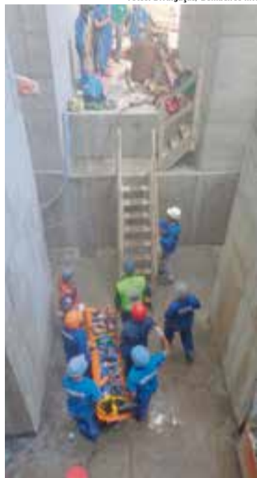
A vítima foi encontrada dentro do canteiro de obras que possuía uma profundidade de 22 metros
