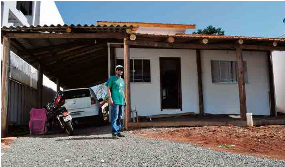
Bras Dutra, em frente à casa construída com o auxílio da comunidade
