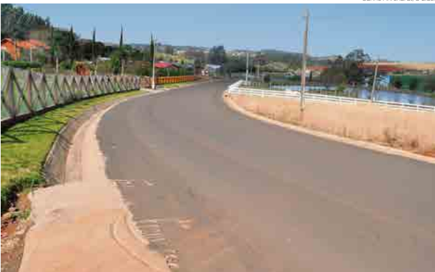
Primeira etapa do asfalto foi concluída em 2017
