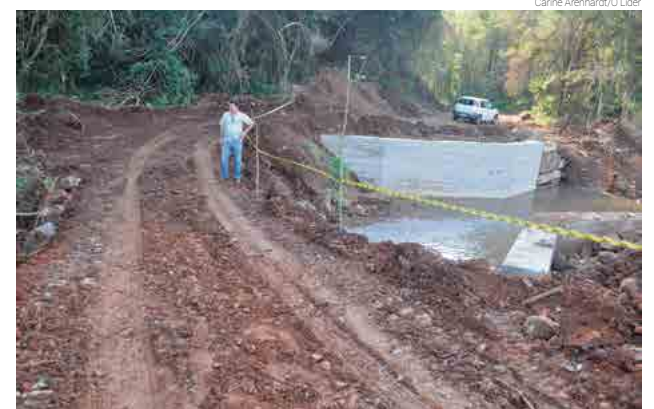
Passagem temporária foi instalada na Linha Barra do Segredo
