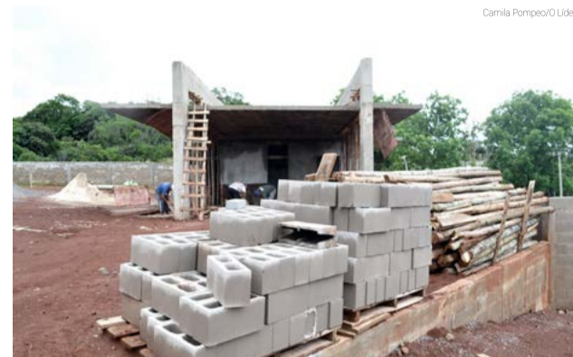
Obras estavam paradas desde o fim do ano passado
