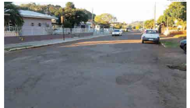
Trecho da José de Anchieta que será asfaltado
