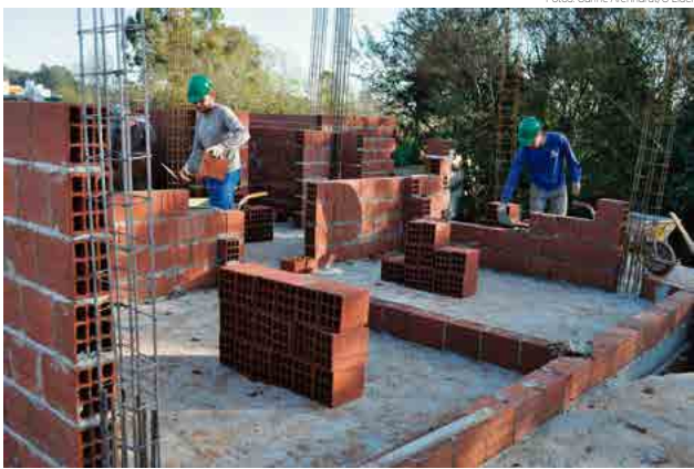
Com a laje concluída, equipe começa a erguer as paredes
