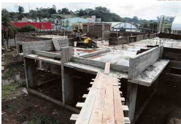
Local só deve ser visitado com agendamento em razão dos equipamentos de proteção no canteiro de obras
