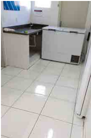
Cozinha da escola foi reformada
