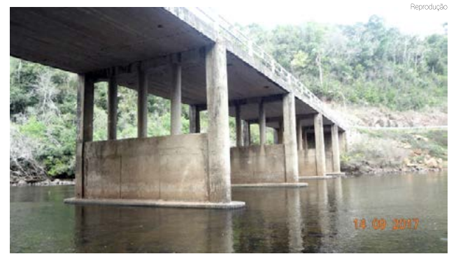
Conclusão foi possível após vistorias periódicas na ponte
