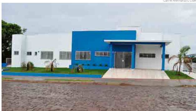
Nova unidade de saúde é construída no Loteamento Estrela
