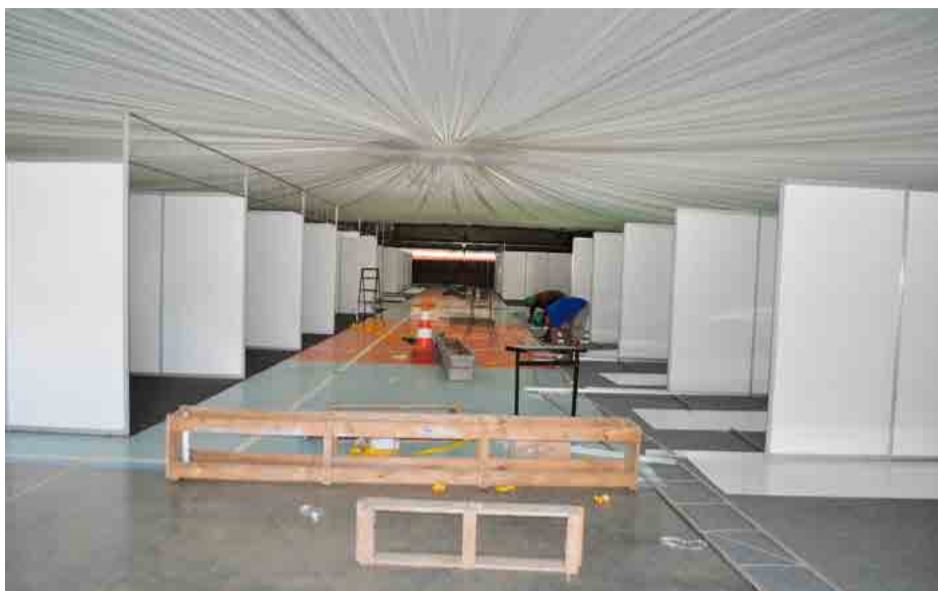
Montagem das estruturas está sendo finalizada
