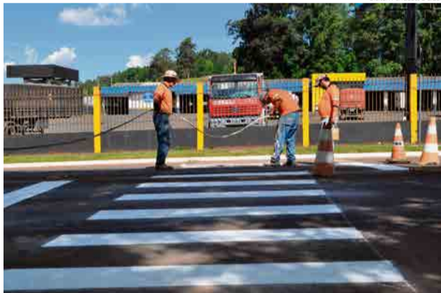
Trabalho começou na Avenida Maravilha
