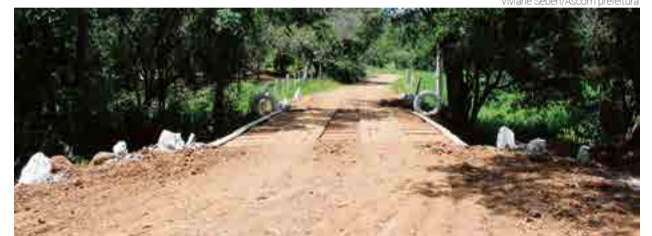
Estrutura da Linha Incaré foi totalmente recuperada
