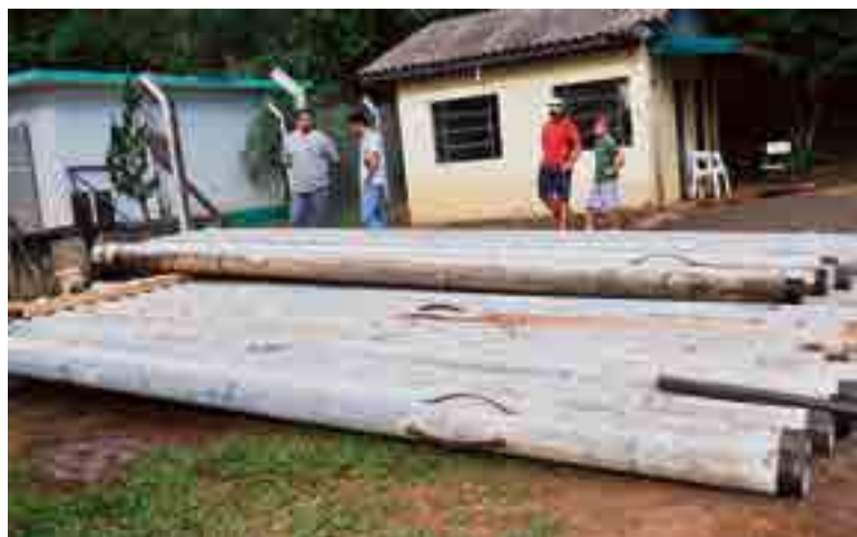
Tubulação corroída está sendo trocada pelos técnicos
