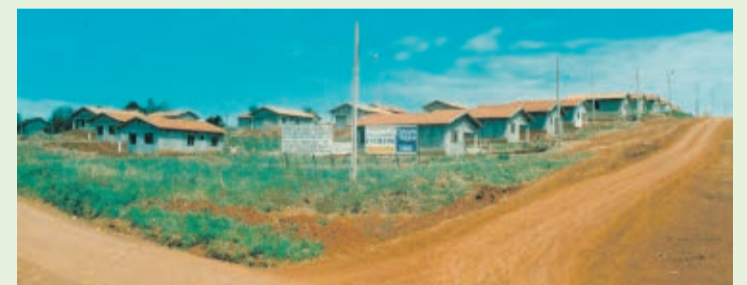
25 casas foram construídas pelo Verde Teto
