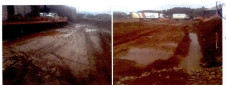
Fotografias 19 a 23: Marginal 190, estaca 190+000 a 190+450 – Realizado a escavação para a implantação da marginal. Para finalizar necessita a execução de serviços de drenagem, camada final, posteriormente a base (BGS) e camada de asfalto. Verificado o acúmulo de água e avanço em processos erosivos, dificultando o acessos dos moradores. Risco de perda dos serviços.
