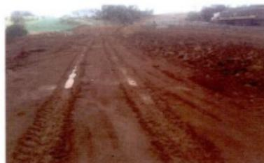
Fotografia 05: Marginal 150, estaca 150+580 – Camada de aterro sem a devida compactação e selamento, favorecendo o acúmulo e penetração de água. Risco de perda de serviços.
