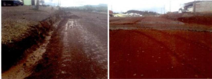
Fotografias 27 a 30: Marginal 180, estaca 183+500 a 184+000 – Iniciado a compactação da camada final, verificado o avanço em processos erosivos e acúmulo de água, dificultando o acesso as propriedades.
