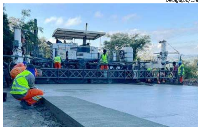
No Oeste, a BR-163 avança com trechos de pavimento em concreto
