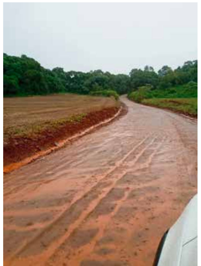
Trecho após trabalho da equipe da Secretaria de Obras
