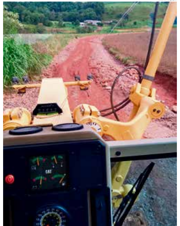
Registro do acúmulo de terra na estrada de acesso a Bom Jesus do Oeste
