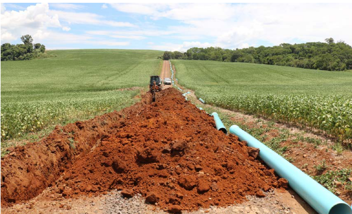
Abertura de valas para colocação da tubulação para puxar água da prainha
