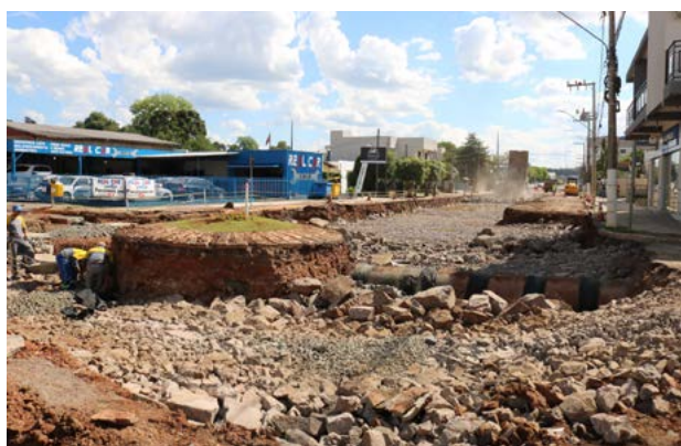
Pontos críticos tiveram reparos profundos na base
