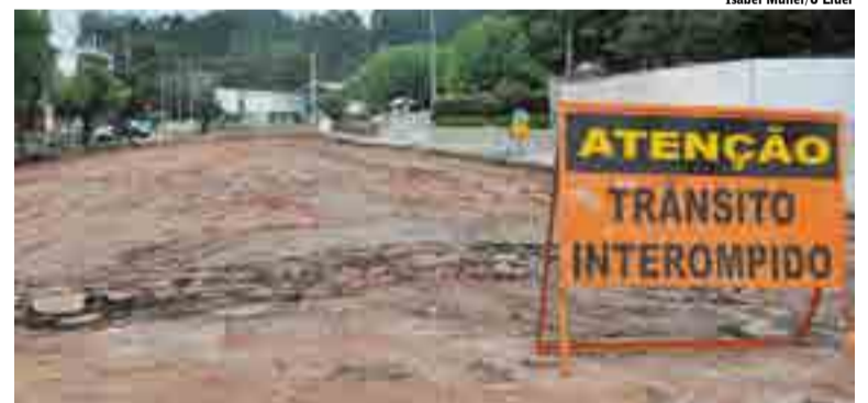
Obras iniciaram na quarta-feira (14)
