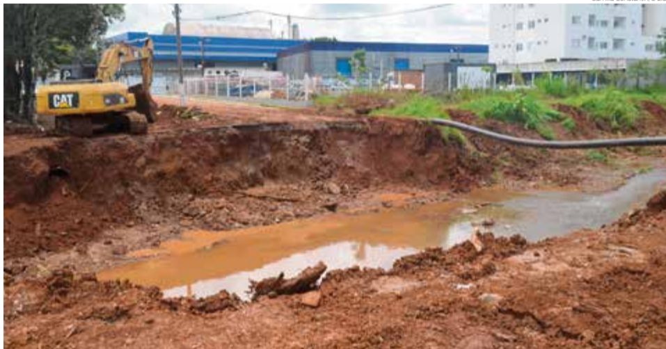
Trabalho é feito na Avenida Orlando Zawadski, que está com tráfego interrompido
