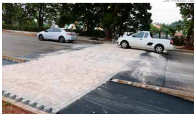
Faixa elevada construída em frente ao Caic
