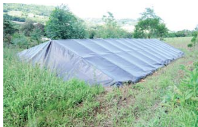
Cisterna não foi suficiente durante a seca
