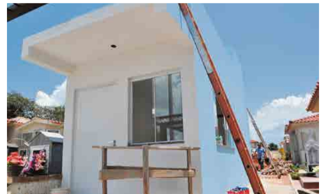
Obra da Casa do Zelador em andamento no Cemitério Municipal
