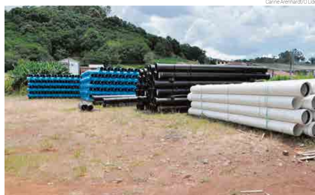
Tubulações de 300 milímetros serão usadas na nova adutora
