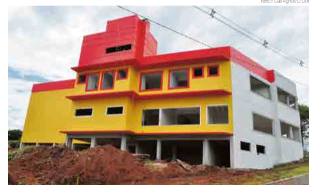
Obra está na fase de pintura e colocação de cerâmicas
