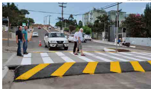
Faixa elevada foi construída no centro da cidade
