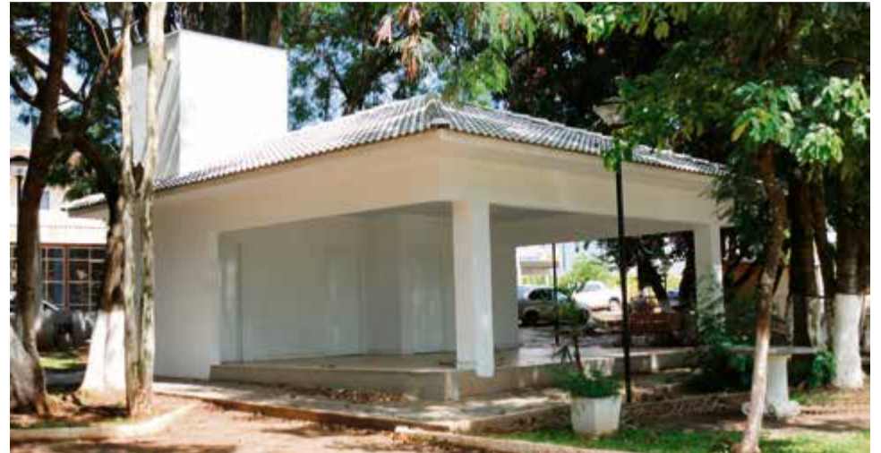
Espaço está sendo construído na Praça dos Motoristas
