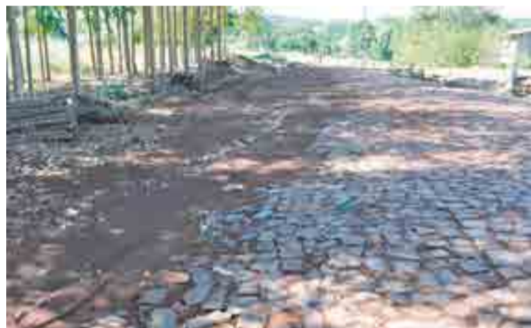
Terra e inço já invadem a parte que está concluída
