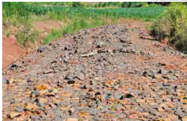
Obra do calçamento está 70% concluída
