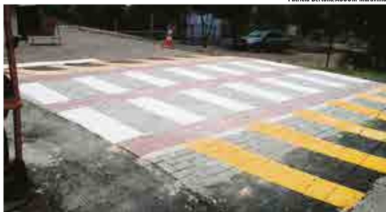
Primeira faixa elevada foi implantada na Rua Hercílio Luz, próximo à igreja da comunidade do Bairro Progresso
