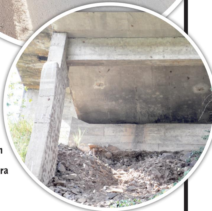
Conforme o engenheiro, as manchas brancas indicam a infiltração de água na estrutura da ponte
