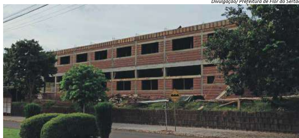
Espaço irá contar com refeitório e salas de aula
