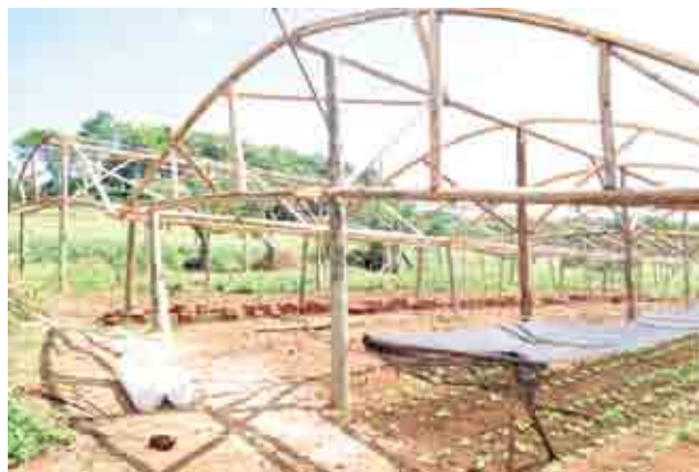
Estufas estão em fase de conclusão
