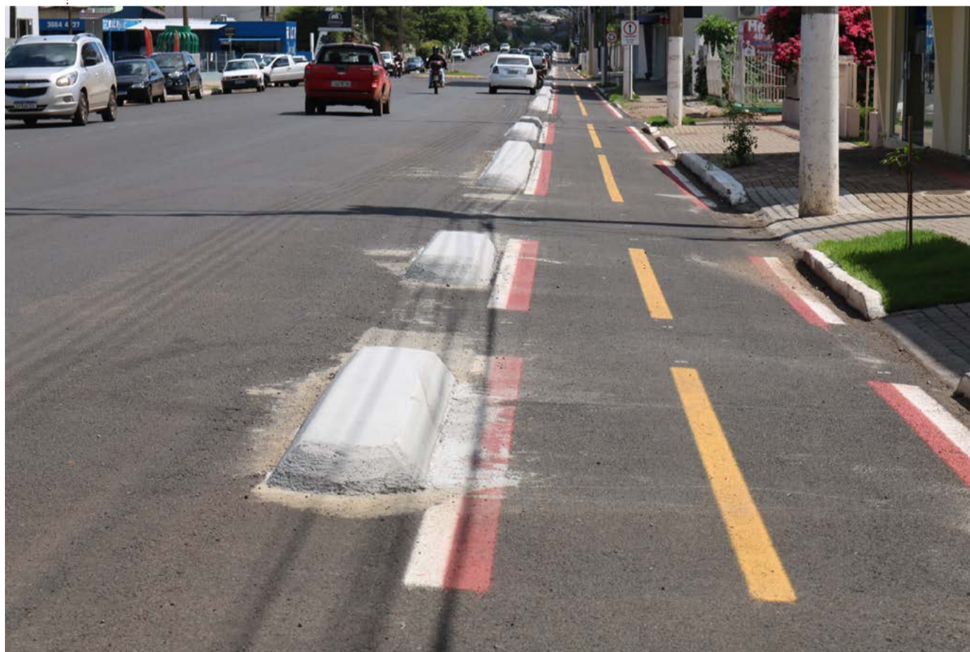
Ciclovia já está implantada em grande parte do trecho de obras
