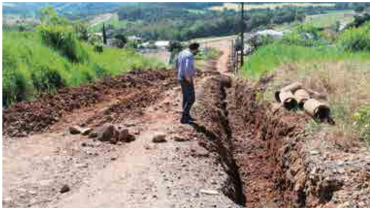
Tubulações são readequadas nas laterais da via no Bairro Bela Vista
