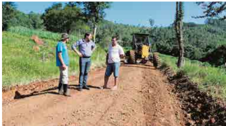
Prefeito acompanhou as obras no interior e conversou com moradores e secretário
