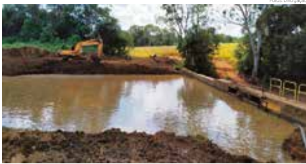
Fotos: Divulgação Bombas retiraram água do Rio Jundiá para o tratamento e distribuição enquanto máquinas fazem o desassoreamento
