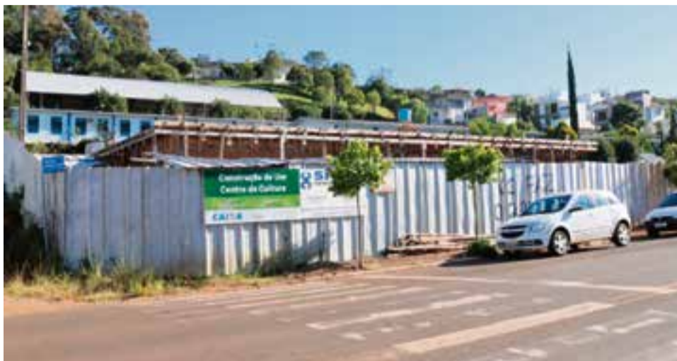
Obra fica localizada na Avenida Presidente Kennedy
