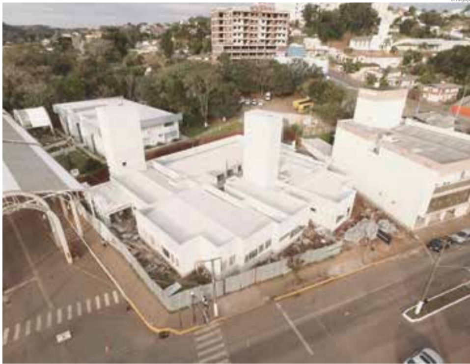
Serão construídos o segundo e o terceiro pavimentos do Centro Especializado em Saúde
