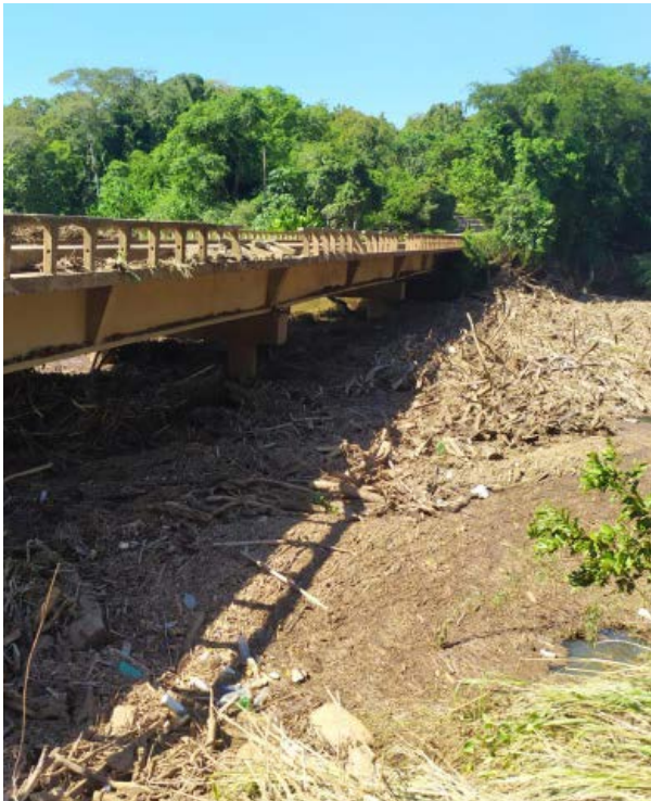
Materiais foram retirados da ponte após a enchente
