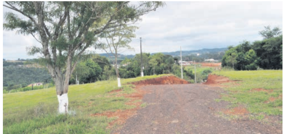
Novo acesso foi aberto para melhorar o trânsito de veículos no parque
