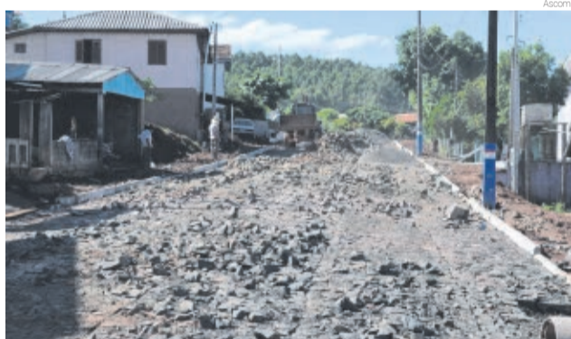
Obras terão um investimento de pelo menos R$ 347 mil
