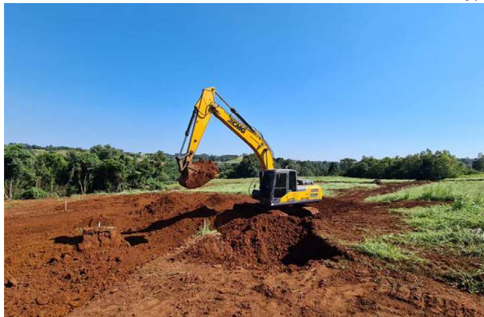
Obra é realizada na Linha 51, interior do município
