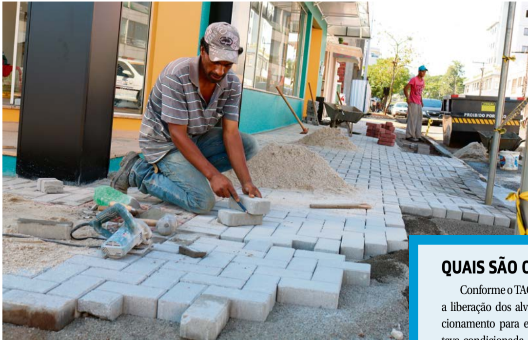
Obras de acessibilidade avançam na cidade
