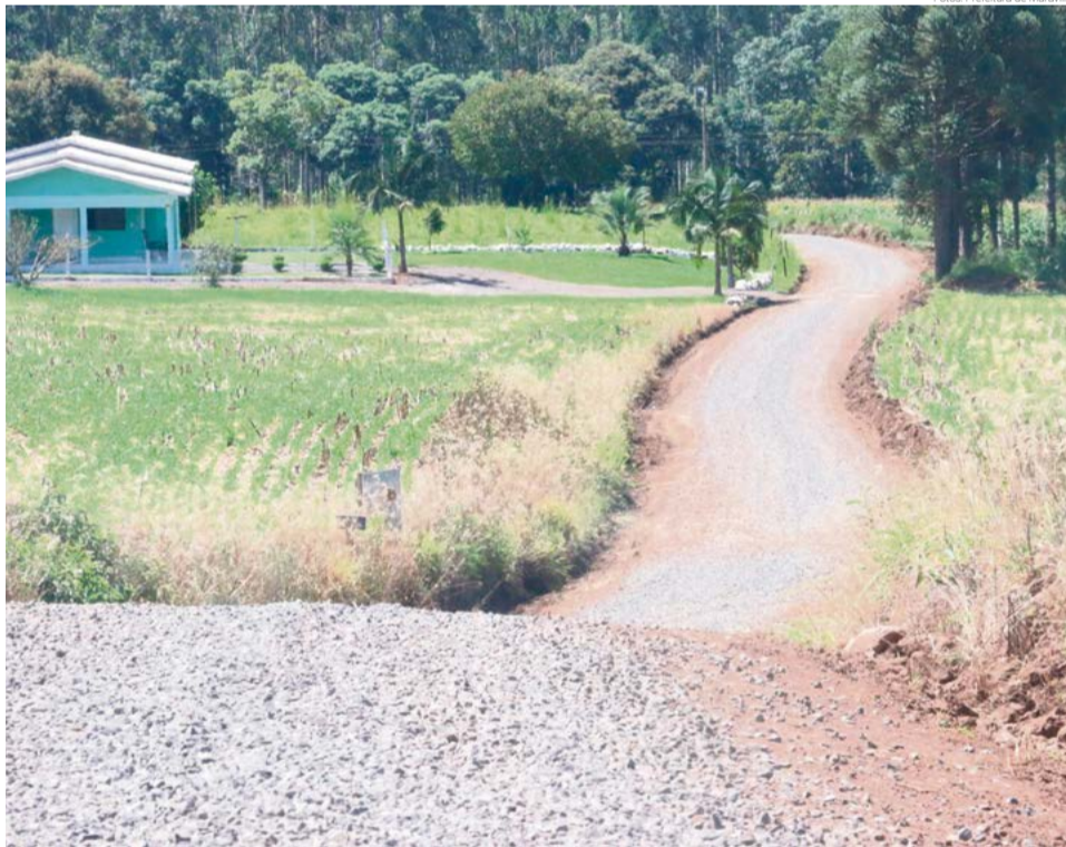
Na Linha Tope da Serra problema foi resolvido com a colocação de brita e será realizada compactação
