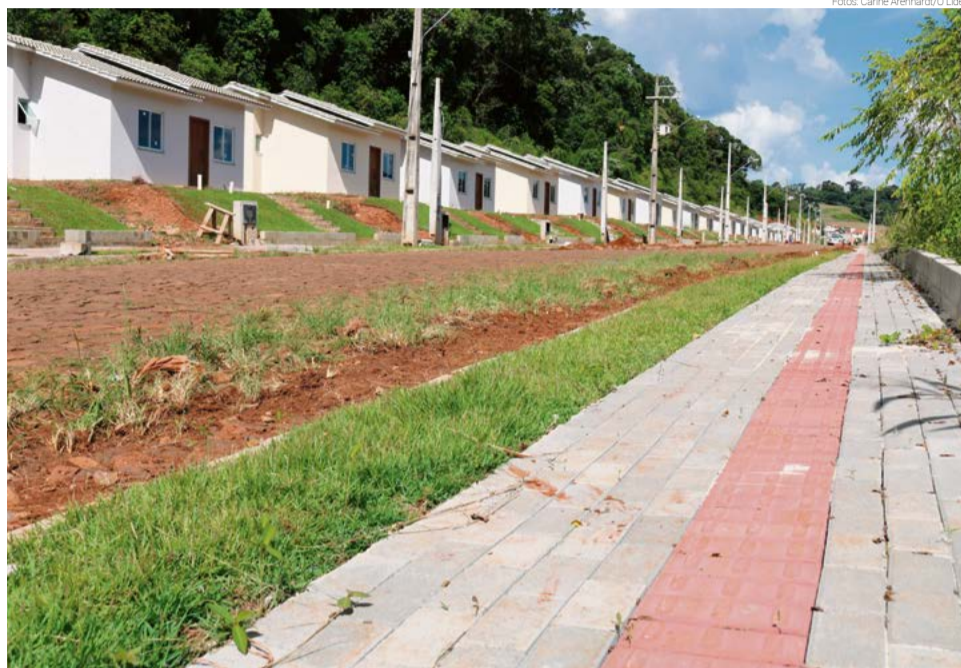
Calçadas na parte interna do loteamento estão prontas
