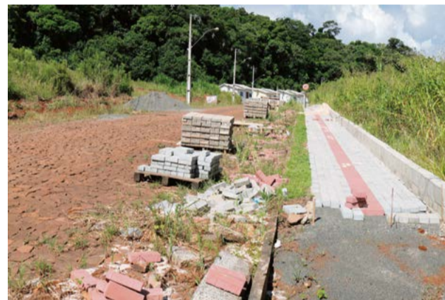
Passeios públicos também serão construídos nas ruas de acesso ao loteamento
