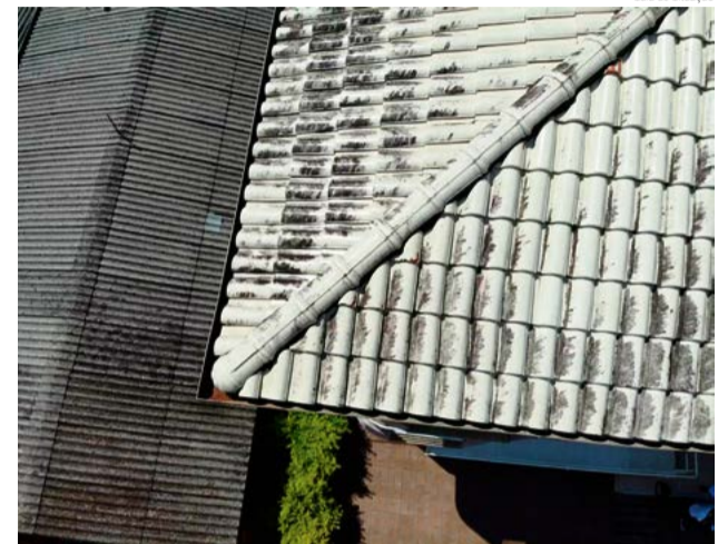
Drone possibilita acesso em calhas que estão instaladas em prédios do centro
