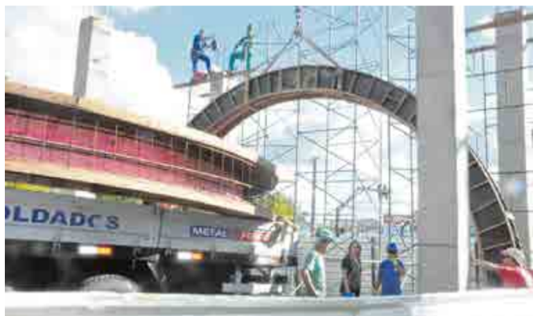
Prefeita acompanhou as obras na Euclides da Cunha durante a semana
