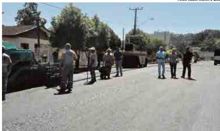
Pavimentação do trecho final da avenida também foi acompanhado
