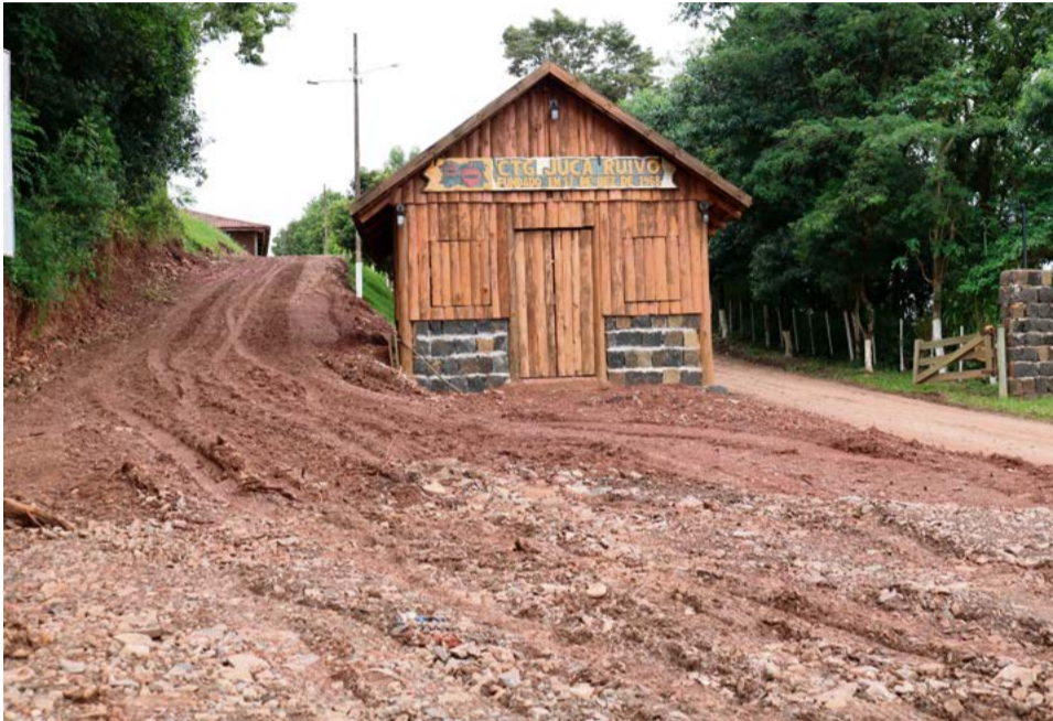
Entrada recebeu melhorias, com alargamento da rua ao lado, que deve ser utilizada para a saída de veículos do estacionamento do parque
