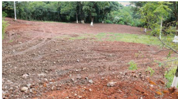
Área já existente foi ampliada e melhorada para abrigar reboques e barracas
