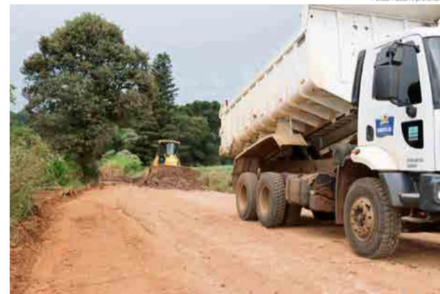
Cascalho foi aplicado e compactado na estrada
