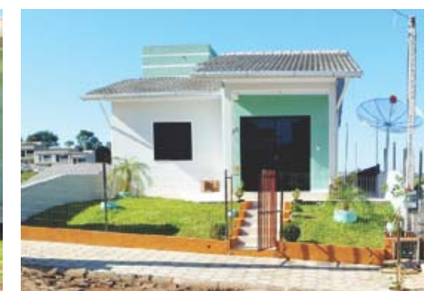
Casa de alvenaria com 2 pisos. Próximo a Unoesc em Maravilha.
